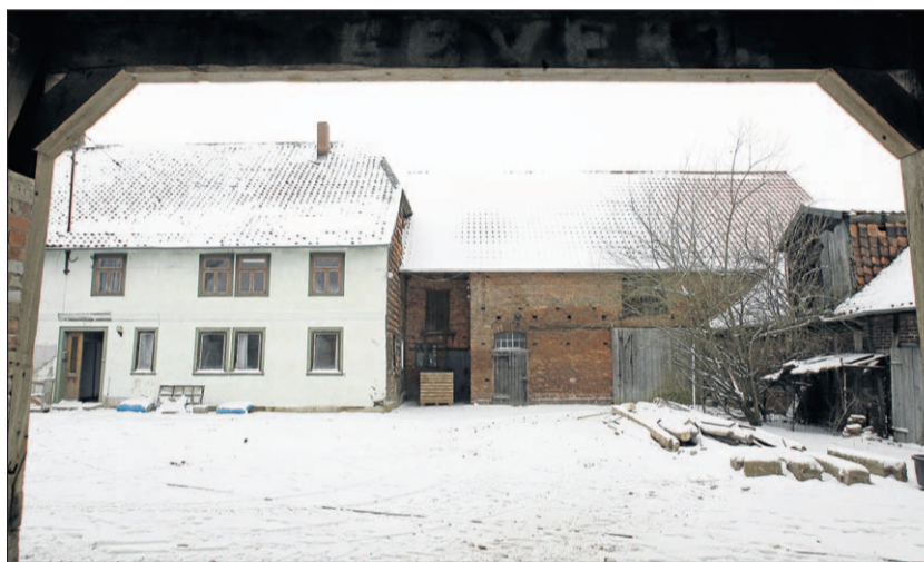
Blick aus der Scheune auf das Wohnhaus (links) und Kuhstall (rechts).
