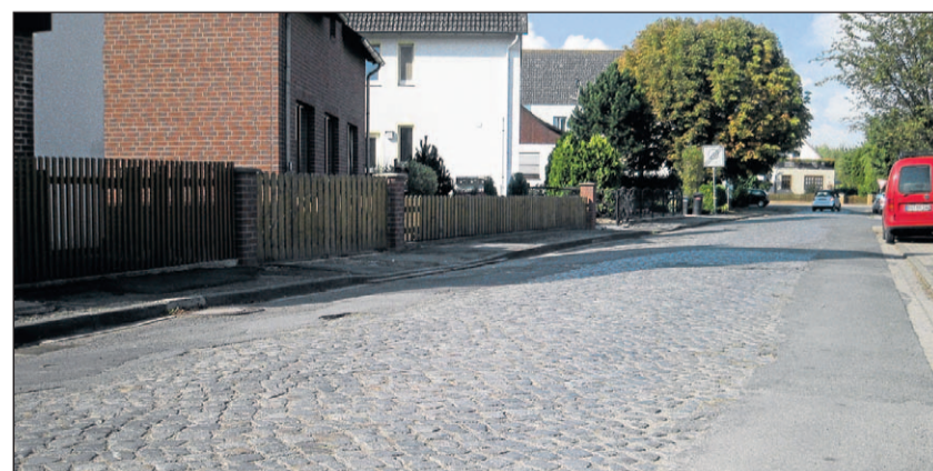
Holperpiste: Die Bahnhofstraße in Groß Gleidingen wird 2011 ausgebaut.
